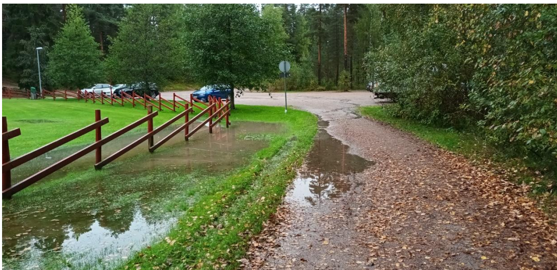
Kuva 8. Sorapäällysteisen pysäköintialueen vedet kertyvät nykytilanteessa pysäköintialueelta etelään lähtevän ajoyhteyden reunaan. [Ramboll 17.9.2025]
