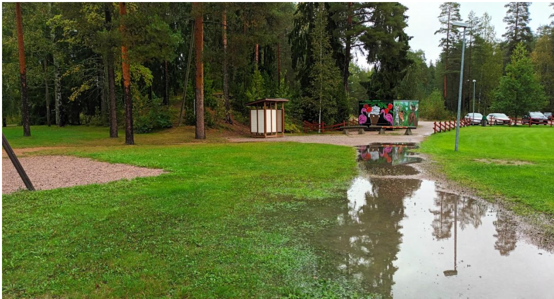
Kuva 10. Yleiskuva rannasta pysäköintialueen suuntaan katsottuna. Sateilla vettä lammikoituu sorapintaisille kulkuväylille. [Ramboll 17.9.2025]
