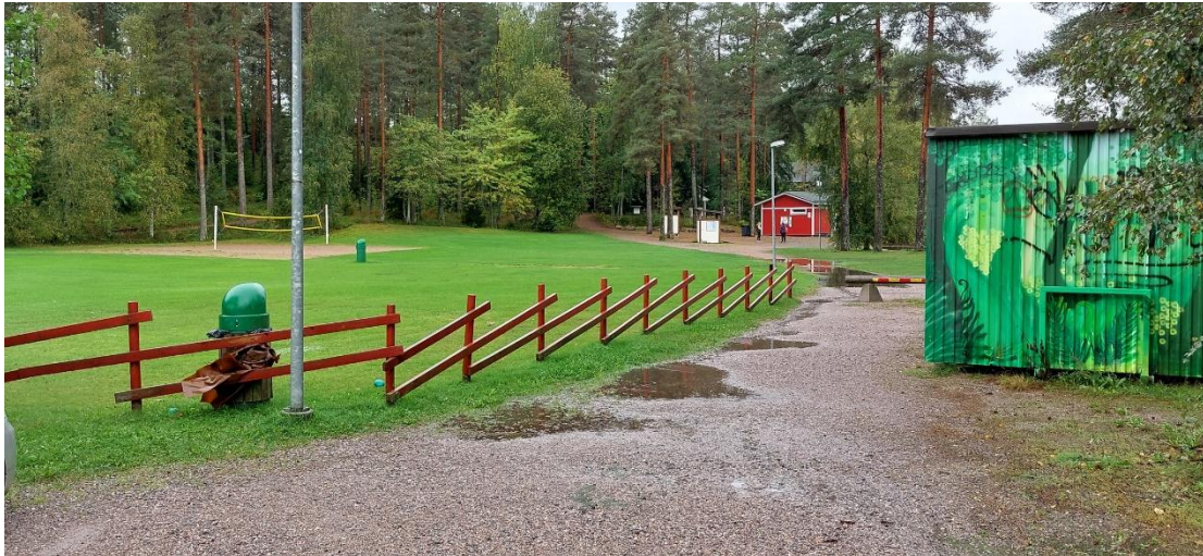
Kuva 9. Nykyinen kulkuyhteys pysäköintialueelta rantaan. Vettä lammikoituu sorapintaiselle väylälle. [Ramboll 17.9.2025]
